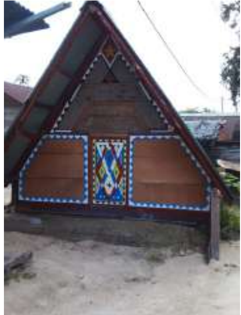
Figuur 8: Bouwwerkzaamheden en restauratie van de marrongebouwen (©Otmar Misiedjan (Bigtoen), 2021
